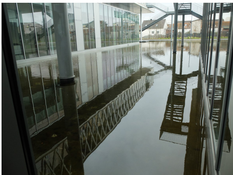
Bâtiment des archives
