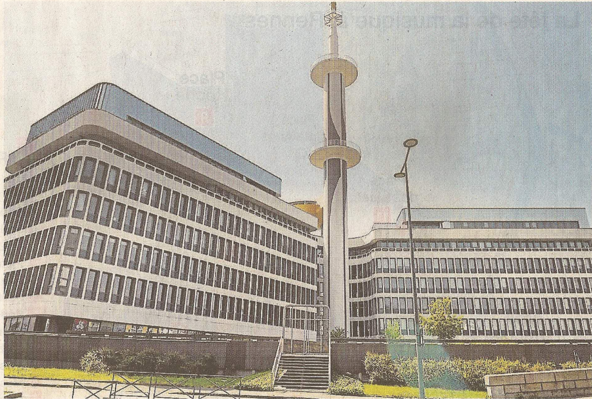
Le Pool est né de la fusion entre la French Tech Rennes Saint-Malo et Rennes Atalante. En novembre, les 25 salariés s'installeront au Mabilay, à Rennes.
