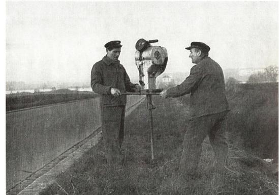
Une fois les poteaux plantés, il faut « tirer » les fils et les tendre. Un premier fil est tiré, il sert ensuite de guide pour tirer 3 autres fils, en utilisant un « curseur » ainsi que le préconise le manuel de 1898. Pour s'assurer que le fil a la bonne tension, un dynamomètre est utilisé.
