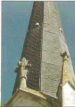
Si, si, il y a bien une antenne dans ce clocher ! Mais elle est dissimulée derrière un panneau d'ardoises synthétiques, lequel laisse bien sûr passer les ondes radio. Les clochers sont souvent utilisés par les opérateurs car leur hauteur est gage d'une bonne couverture.
